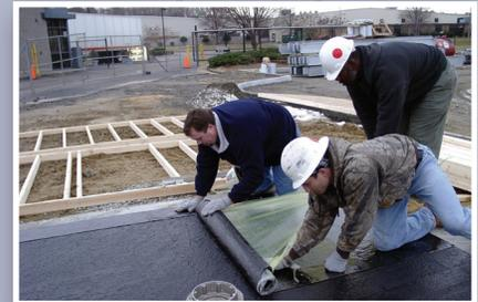
Para impermeabilizar losas elevadas, seleccione de una gama versátil de membranas asfálticas: PENNCOAT™ 101 Membrane aplicada en caliente, TUFCEM™ II Membrane aplicada en frío o PENNCOAT™ 600 Membrane unida por adhesivo.
