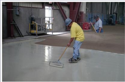
Recubrimientos aplicables con llana y autonivelantes PENNTROWEL™ Systems y revestimientos de polímero laminado brindan protección duradera contra la corrosión para pisos y otras estructuras de concreto.
